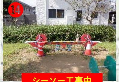
シーズン工事中
